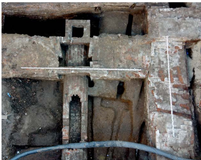
Рис. 3. Фундамент Воскресенского собора на уровне материка, западная часть. Отопительная система и основание колокольни (вид сверху).
