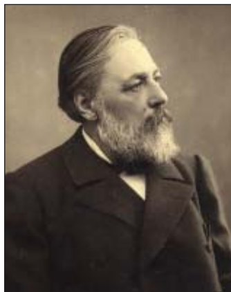
Рис. 16. А.А. Штукенберг. Фотография.
