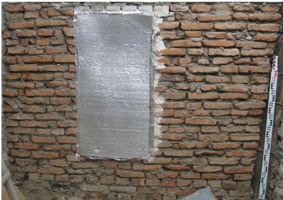
Рис. 3. Стена современной постройки, частично выложенная кирпичами золотоордынского времени.
